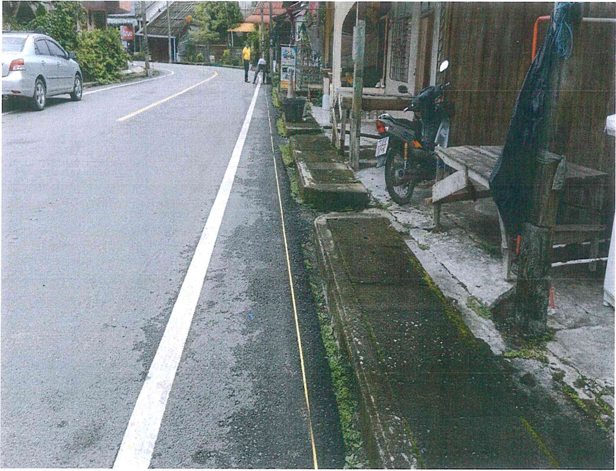
โครงการก่อสร้างระบายน้ำสายมัธยมิตตาราม ก่อนดำเนินการ
