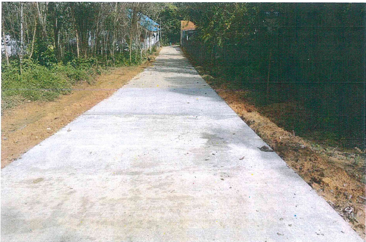
โครงการก่อสร้างถนนคอนกรีตเสริมเหล็กสายบุกเบิกหมอนัด หลังดำเนินการก่อสร้าง
