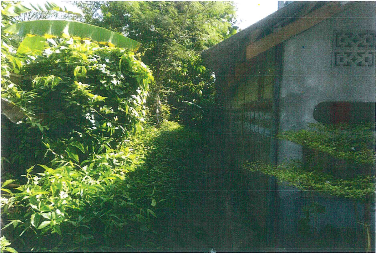
โครงการปรับปรุงก่อสร้างคูระบายน้ำคอนกรีตเสริมเหล็กสายกุงถึงคูระบายน้ำหลังชุมสายโทรศัพท์ ก่อนดำเนินการก่อสร้าง
