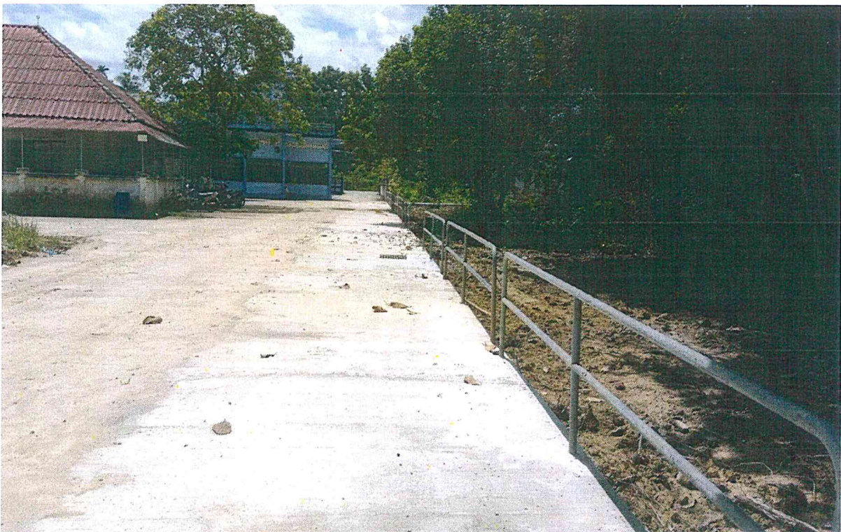
โครงการก่อสร้างระบายน้ำคอนกรีตเสริมเหล็กสายข้างมัธยมเราะห์มานียะห์ หลังดำเนินการก่อสร้าง
