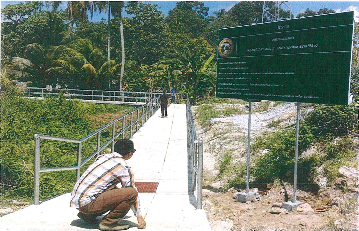
โครงการปรับปรุงก่อสร้างระบายน้ำสายปะจुरอยะ หลังดำเนินการก่อสร้าง
