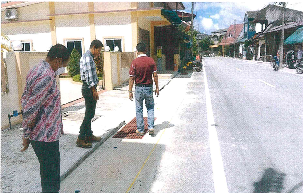
โครงการก่อสร้างคูระบายน้ำสายมัสยิดดาราม หลังดำเนินการ
